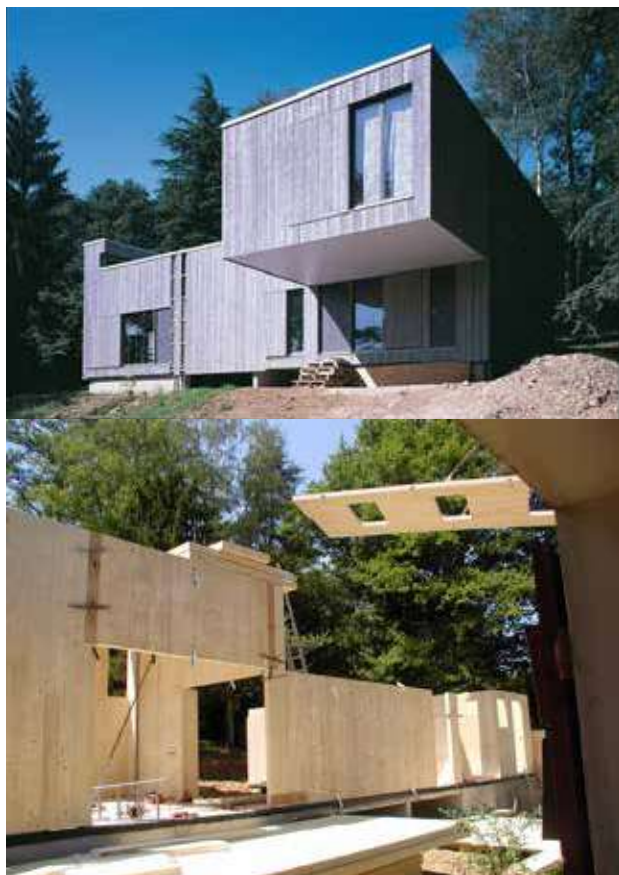
Woning, Frankrijk- voorzien van houten vloeren
