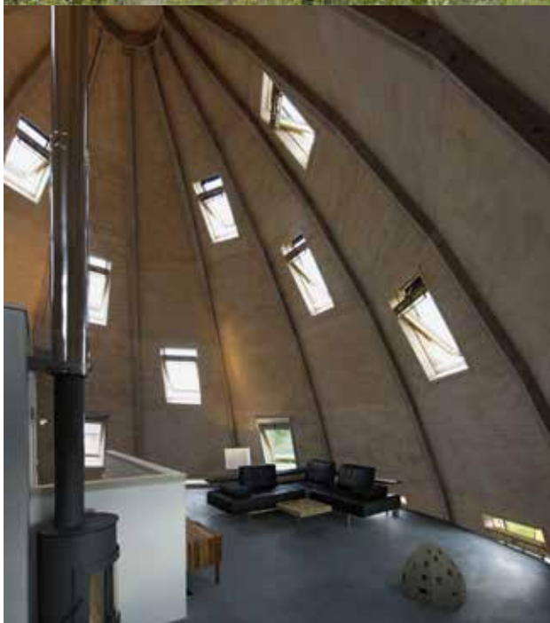
Woning 'De Korf', Almere - bijzondere vorm met lichte staalconstructie en houten binnenspouwblad
