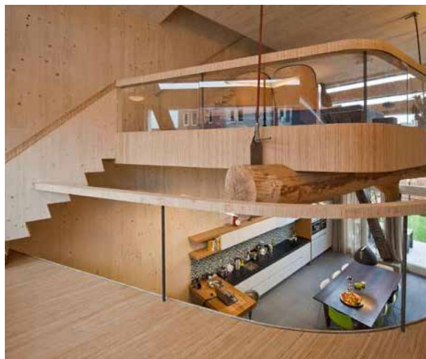
Woning, IJburg- Energie neutraal woonhuis in houtmassiefbouw volledig houten casco
