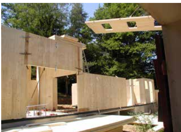
Woning, Lyon, Frankrijk houtmassiefbouw wanden en vloeren met grote uitkragingen
