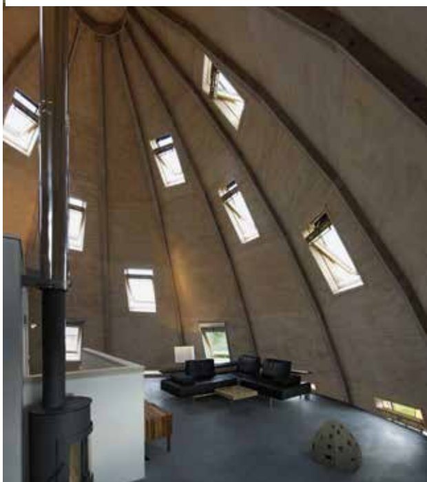
Woning 'De Korf', Almere- bijzondere vorm met lichte staalconstructie en houten binnenspouwblad
