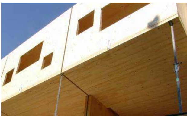
Woning, Lyon, Frankrijk houtmassiefbouw wanden en vloeren met grote uitkragingen
